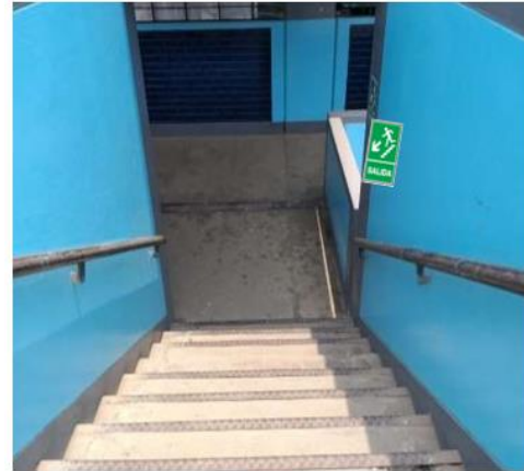
Imagen 19: Cartel de seguridad – ruta de evacuación en escalera
